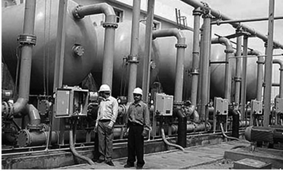
वेस्ट वॉटर ट्रीटमेंट प्लान्ट
